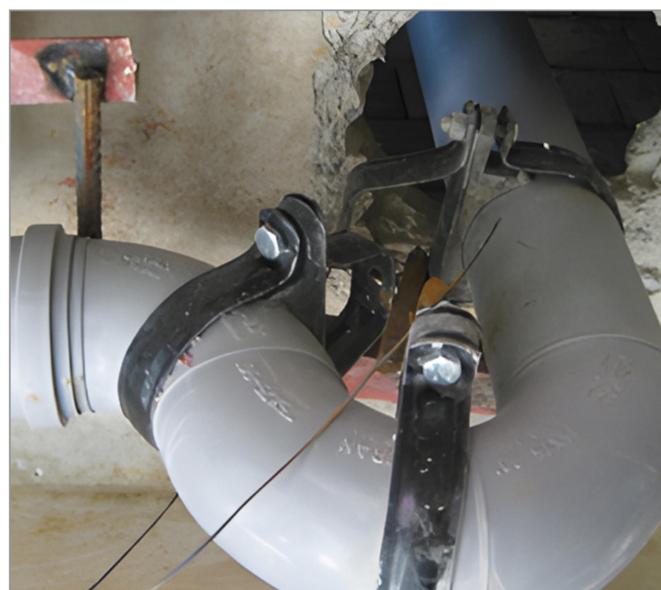
توصیه می شود تمام کر گیری ها (سوراخ کاری) برای جانمایی لوازم بهداشتی و همچنین محل عبور خط قائم با توجه به نقشه های ارائه شده از طرف کارفرما و با هماهنگی ناظر کارگاه قبل از اجرای هرگونه لوله کشی انجام گیرد. توجه: انجام این عملیات بعد از اجرای لوله های قائم توصیه نمیشود.
